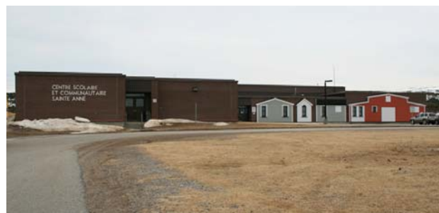
Centre scolaire et communautaire Ste-Anne Photo : ARCO
