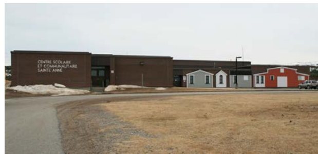
Centre scolaire et communautaire Ste-Anne Photo : ARCO
